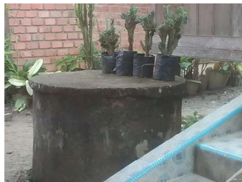
Gambar 6. Sumur sebagai sumber air bersih
